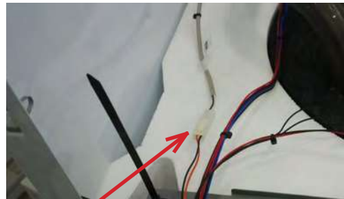
Spojenie konektorov NTC snímača externého zásobníka s konektorom na kabeláži kotla
